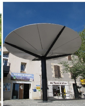
Structure métallique d'ombrière photovoltaïque
